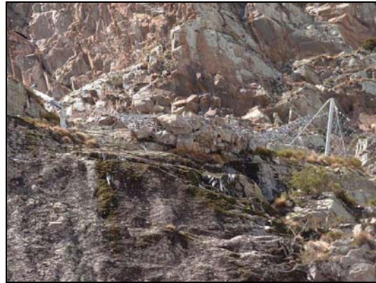
Figura 21: Masa parada por una de las barreras superiores en el desprendimiento de abril del 2003.
