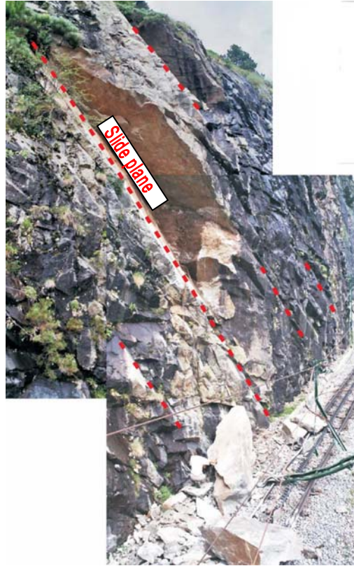
Figura 8: Desprendimiento del 15 de junio del 2003. El área rayada en rojo indica la superficie de deslizamiento.
