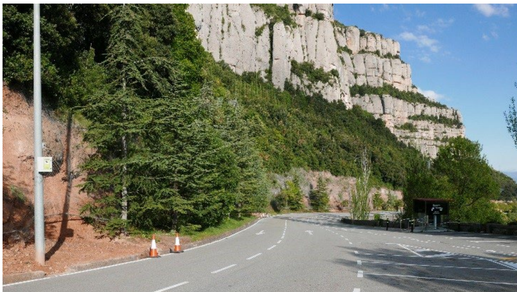
Vista dels talussos propers a l'aparcament del Monestir de Montserrat.
